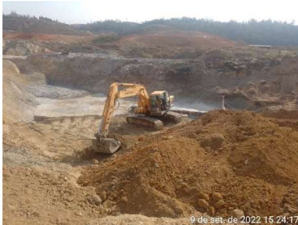
Foto 249 – Vista da realização da atividade de escavação na frente de serviço. (Data:09/09/2022)
