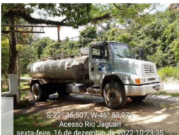
Foto 217 – Abastecimento do Caminhão-Pipa para a realização da umectação das vias internas e externas da obra. (Data:16/12/2022)
