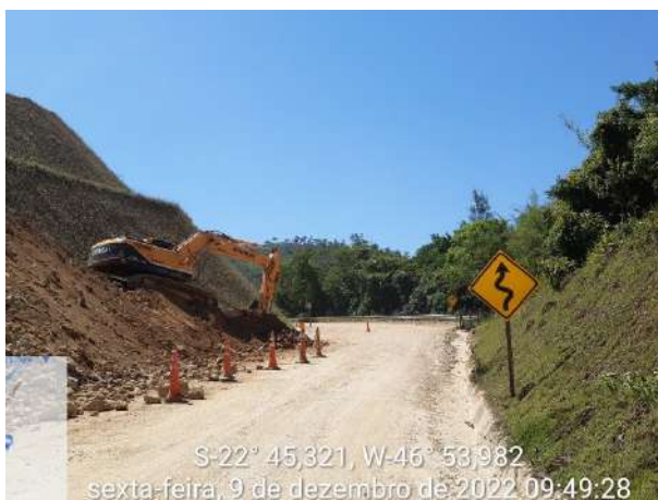
Foto 161 – Sinalização vertical implantada na via interna da obra. (Data:09/12/2022)
