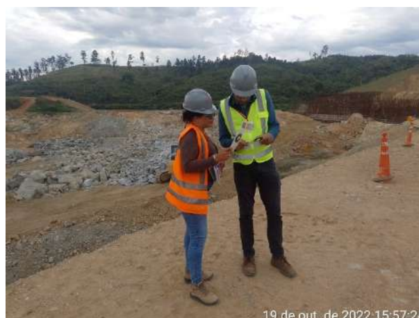
Foto 14 – Treinamento sobre Fumaça Preta, realizado com a equipe do meio ambiente no canteiro da fundação. (Data:19/10/2022)
