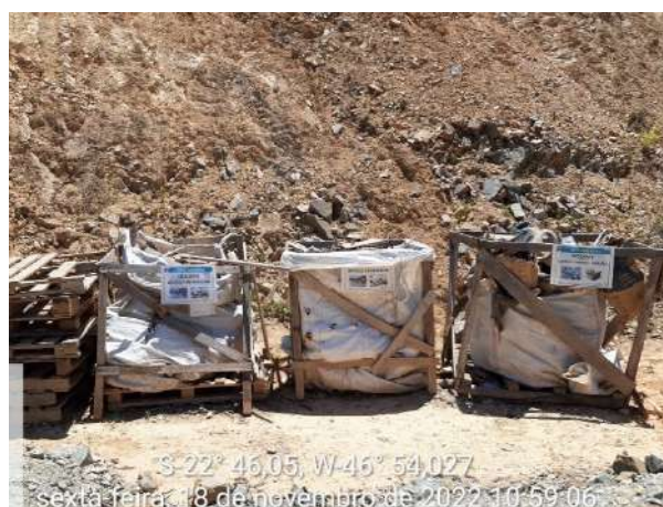
Foto 242 – Vista da área destinada para descarte de madeira na frente de serviço. (Data:18/11/2022)
