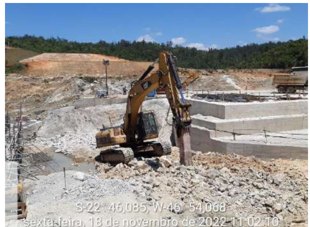
Foto 258 – Vista geral das atividades de trituração de rocha. (Data:18/11/2022)
