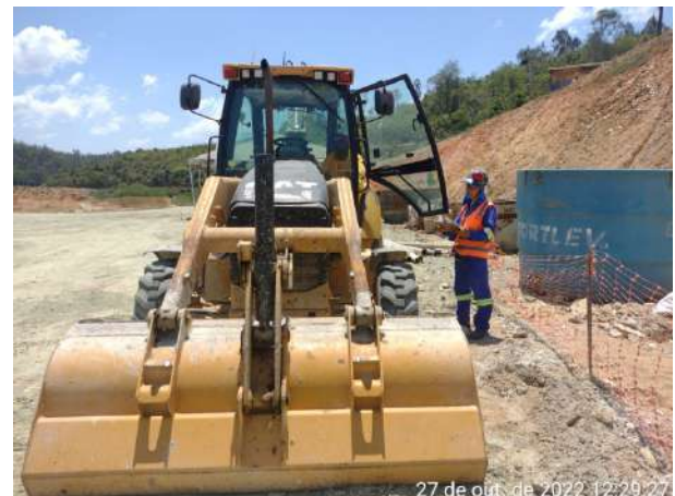
Foto 98 – Retroescavadeira inspecionada na frente de serviço. (Data:27/10/2022)
