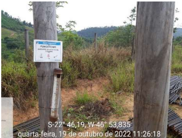
Foto 87 – Reutilização de sobras de materiais, cano PVC, na fabricação de cinzeiros e bituqueiras para serem disponibilizados na frente de serviço. (Data:19/10/2022)
