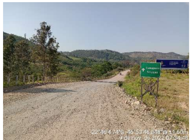
Foto 160 – Sinalização vertical implantada em via externa. (Data:09/11/2022)
