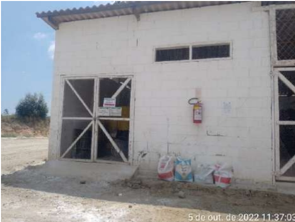
Foto 33 – Vista geral da baía de armazenamento de Produtos Perigosos na oficina mecânica. (Data:05/10/2022)
