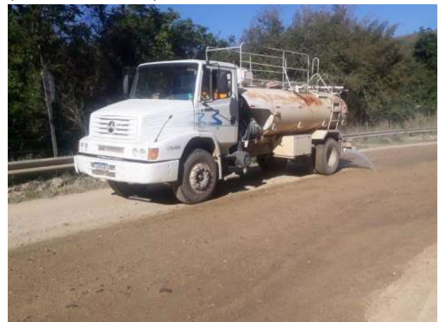
Foto 214 – Realização da umectação nas vias externas MD03. (Data:26/10/2022)
