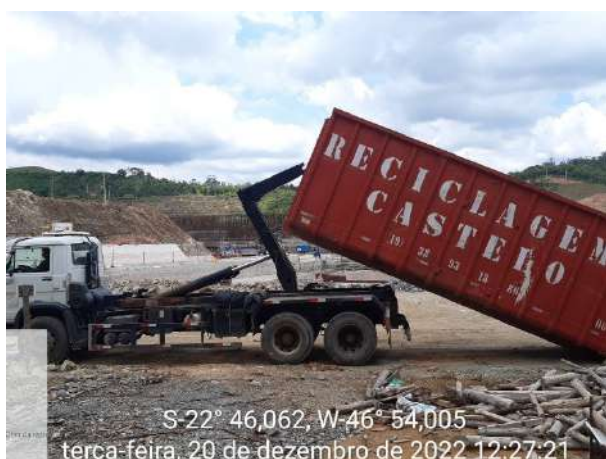
Foto 247 – Retirada de resíduos de madeiras para reciclagens. (Data:20/12/2022)
