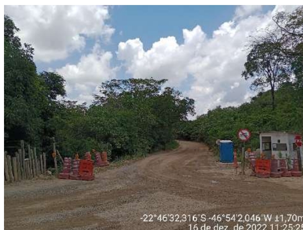
Foto 164 – Sinalização vertical implantada na via externa da obra. (Data:16/12/2022)
