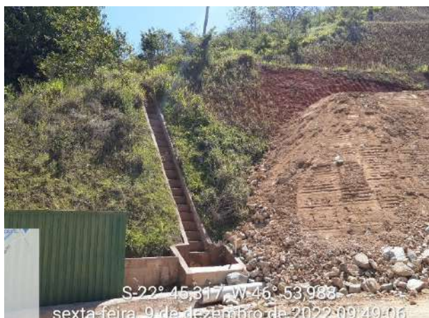
Foto 175 – Escada hidráulica implantada na estrada de acesso ao empreendimento. (Data:09/12/2022)
