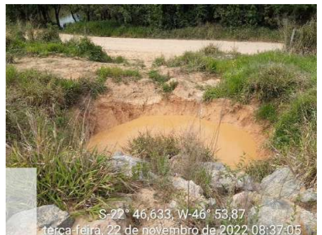
Foto 174 – Cacimba após manutenção implantada em via externa do empreendimento. (Data:22/11/2022)
