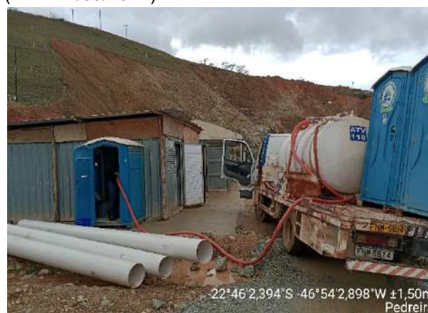
Foto 190 – Vista da realização da limpeza de um dos sanitários químicos disponíveis na frente de serviço. (Data:28/09/2022)
