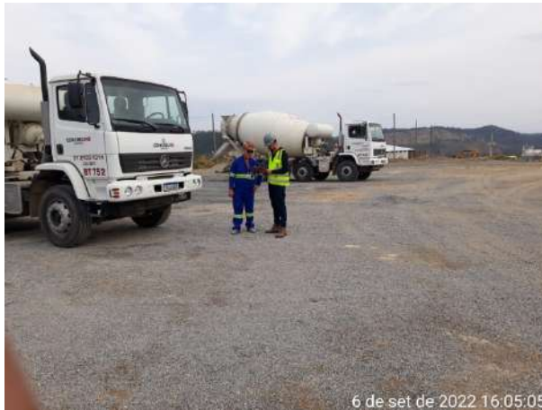
Foto 93 – Caminhão Betoneira inspecionado na frente de serviço. (Data:06/09/2022)
