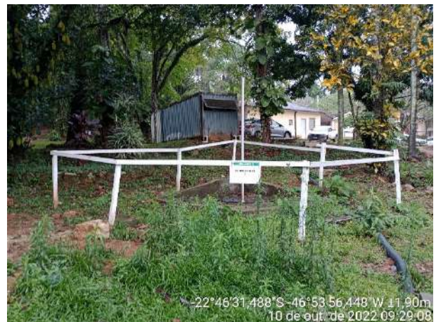
Foto 196 – Biodigestor 02 no canteiro administrativo. (Data:10/10/2022)
