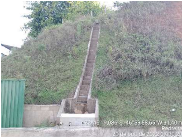
Foto 169 – Escada hidráulica implantada na estrada de acesso ao empreendimento. (Data:20/10/2022)
