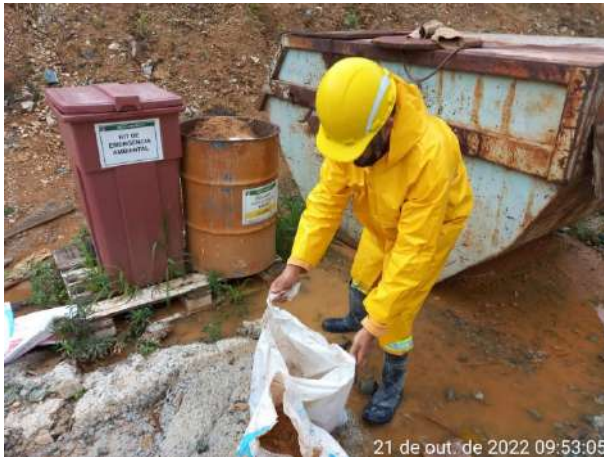
Foto 57 – Limpeza e organização no canteiro da fundação. (Data:21/10/2022)
