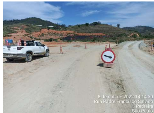
Foto 154 – Sinalização com cones implantada em via interna. (Data:08/10/2022)
