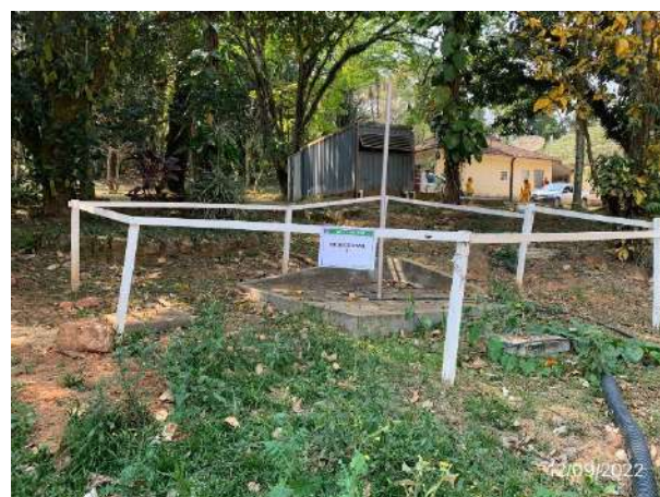
Foto 188 – Biodigestor 02 no canteiro administrativo. (Data:12/09/2022)
