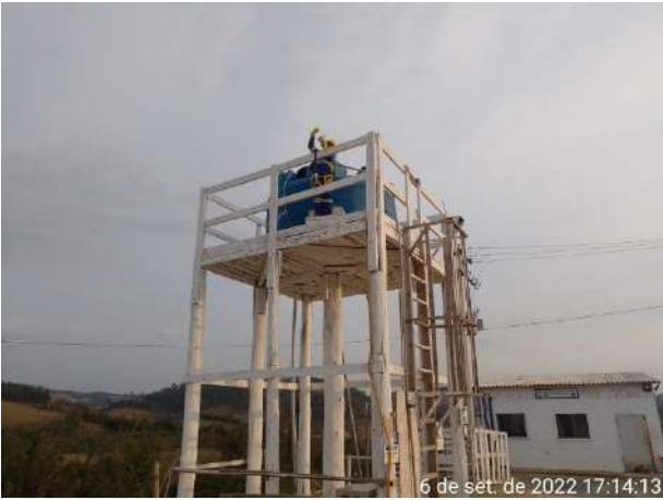
Foto 70 – Adequação de dosagem de cloro na frente de serviço. (Data:06/09/2022)
