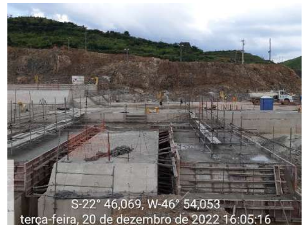
Foto 262 – Vista geral das atividades construtivas da fundação. (Data:20/12/2022)
