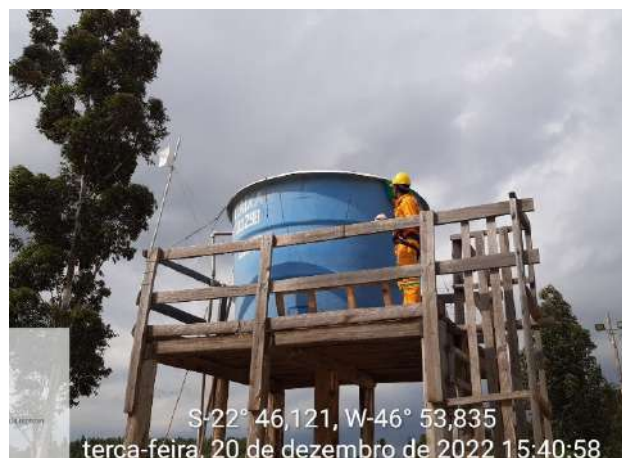
Foto 82 – Adequação de dosagem de cloro na caixa de água disposta na frente de serviço. (Data:20/12/2022)
