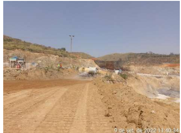
Foto 212 – Realização da umectação das vias internas da frente de serviço na fundação. (Data:09/09/2022)
