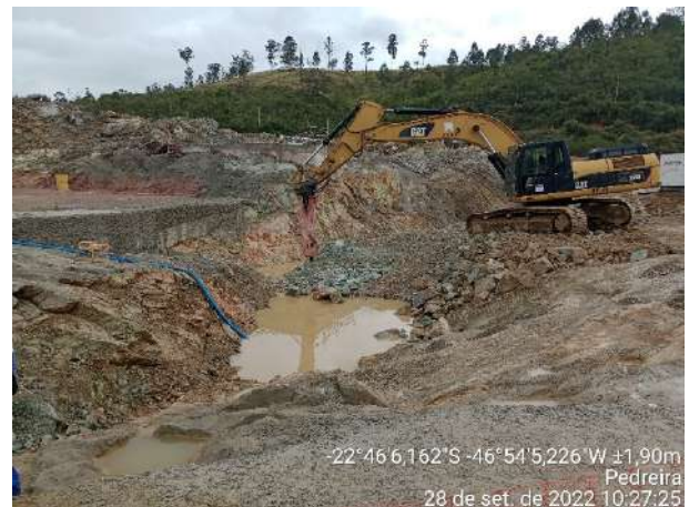
Foto 252 – Vista da realização das atividades de limpeza rigorosa na fundação. (Data:28/09/2022)
