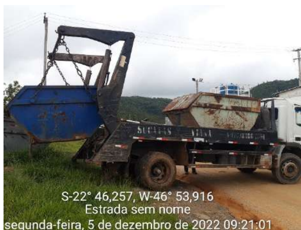
Foto 246 – Troca de caçamba de resíduo comum do canteiro industrial. (Data:05/12/2022)
