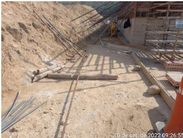
Foto 55 – Limpeza e organização na frente de serviço. (Data:10/09/2022)
