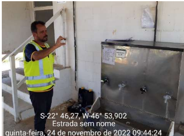
Foto 79 – Coleta de água para análise de potabilidade – Bebedouro do Canteiro de obra. (Data:24/11/2022)
