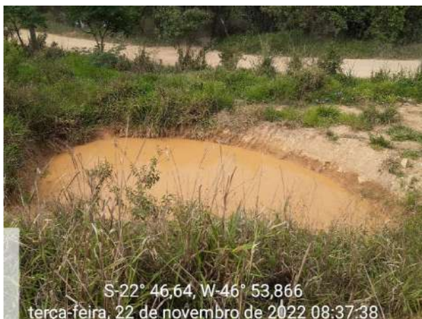
Foto 173 – Cacimba após manutenção implantada em via externa do empreendimento. (Data:22/11/2022)
