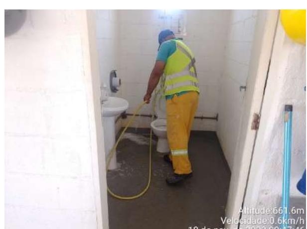
Foto 62 – Limpeza e organização dos banheiros da usina de concreto. (Data:18/11/2022)
