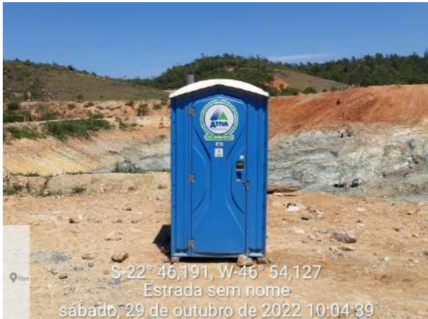
Foto 193 – Vista do sanitário químico disponível na frente de serviço. (Data:29/10/2022)
