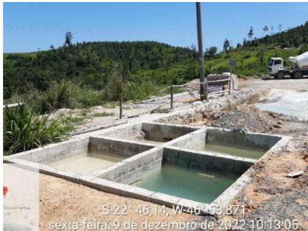
Foto 185 – Sistema de Tratamento de Efluentes utilizado para coleta de resíduos de concreto das betoneira. (Data:09/12/2022)
