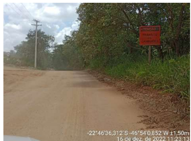
Foto 162 – Sinalização vertical implantada na via externa da obra. (Data:16/12/2022)
