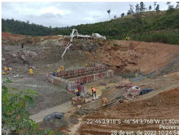
Foto 251 – Vista da realização das atividades de limpeza rigorosa na fundação. (Data:28/09/2022)
