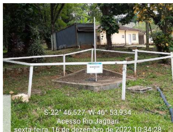
Foto 204 – Biodigestor 02 no canteiro administrativo. (Data:16/12/2022)
