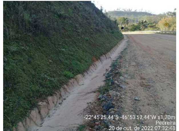
Foto 170 – Sistema de drenagem implantada na estrada de acesso ao empreendimento. (Data:20/10/2022)
