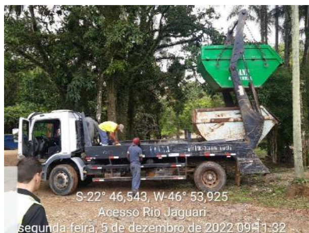
Foto 245 – Troca de caçamba de resíduo comum do canteiro administrativo. (Data:05/12/2022)
