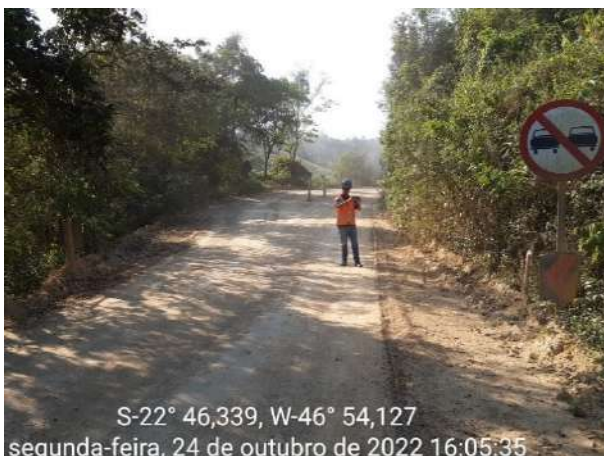
Foto 155 – Sinalização vertical implantada na via interna da obra. (Data:24/10/2022)
