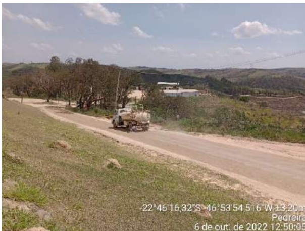
Foto 213 – U Realização da umectação das vias internas do canteiro industrial. (Data:06/10/2022)
