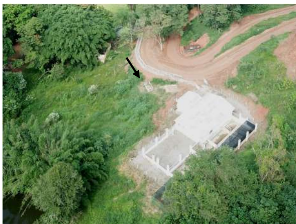
Foto 209 – Localização do Biodigestor 03 na base de fauna.
