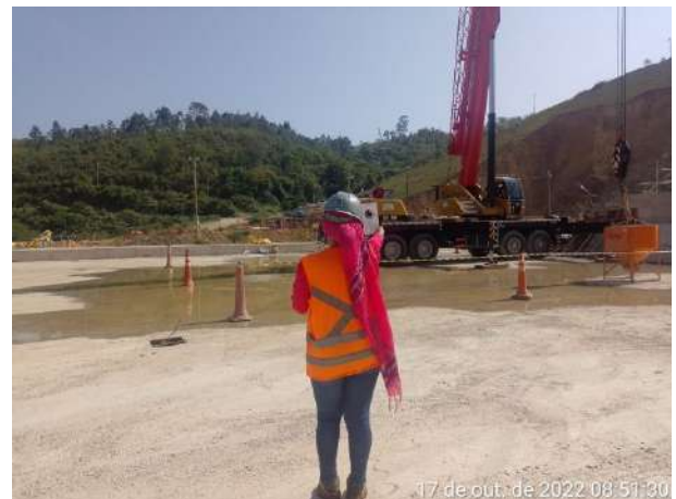
Foto 220 – Medição de fumaça preta em caminhão guindaste. (Data:17/10/2022)
