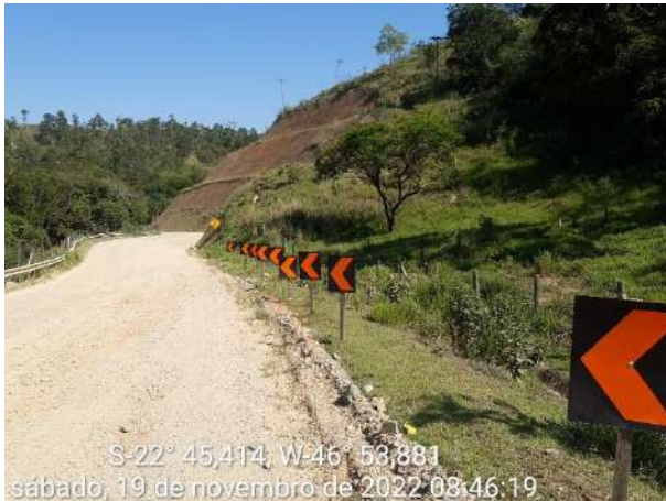
Foto 157 – Sinalização vertical implantada em via externa. (Data:19/11/2022)
