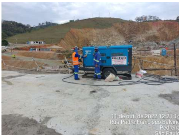
Foto 97 – Compressor inspecionado na frente de serviço. (Data:11/10/2022)
