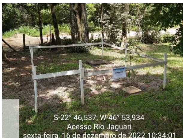
Foto 203 – Biodigestor 01 no canteiro administrativo. (Data:16/12/2022)
