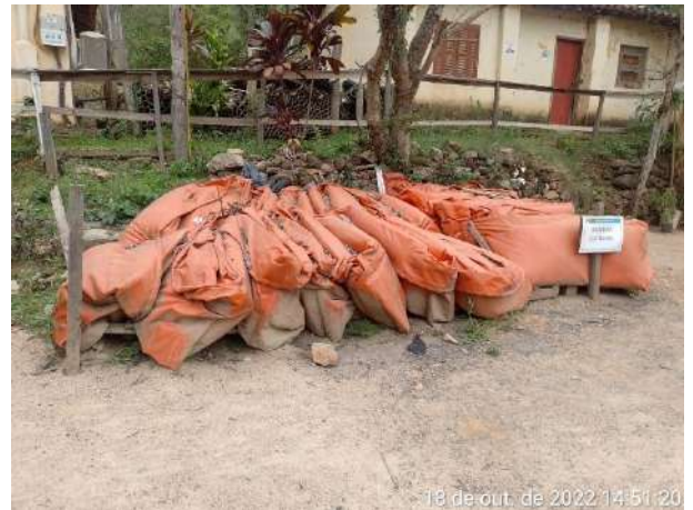
Foto 48 – Kit de emergência ambiental no canteiro administrativo. (Data:18/10/2022)
