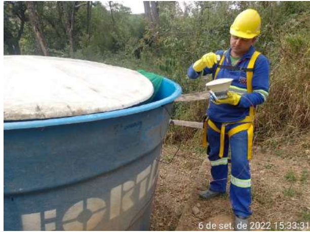
Foto 69 – Adequação de dosagem de cloro na frente de serviço. (Data:06/09/2022)
