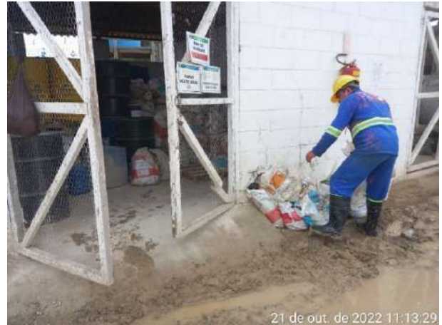
Foto 34 – Organização da baía de armazenamento de Produtos Perigosos na oficina mecânica. (Data:21/10/2022)
