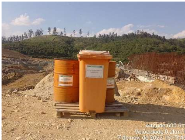
Foto 49 – Kit de emergência ambiental no canteiro da fundação. (Data:07/11/2022)
