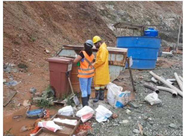
Foto 58 – Limpeza e organização no canteiro da fundação. (Data:21/10/2022)
