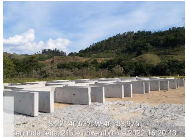
Foto 64 – Limpeza e organização na frente de serviço do Pátio de Pré-Moldados. (Data: 21/11/2022)
