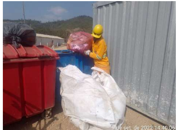
Foto 54 – Limpeza e organização no canteiro da oficina mecânica. (Data:09/09/2022)
