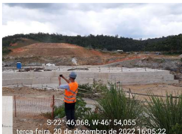
Foto 264 – Vista geral das atividades construtivas da fundação. (Data:20/12/2022)
