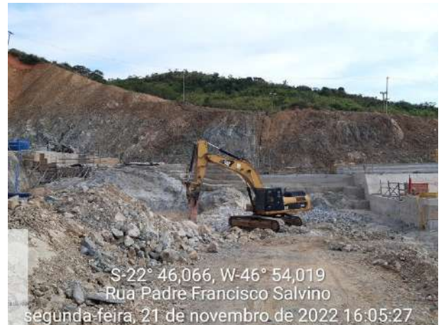
Foto 260 – Vista da realização das atividades de trituração de rocha na frente de serviço. (Data:21/11/2022)
