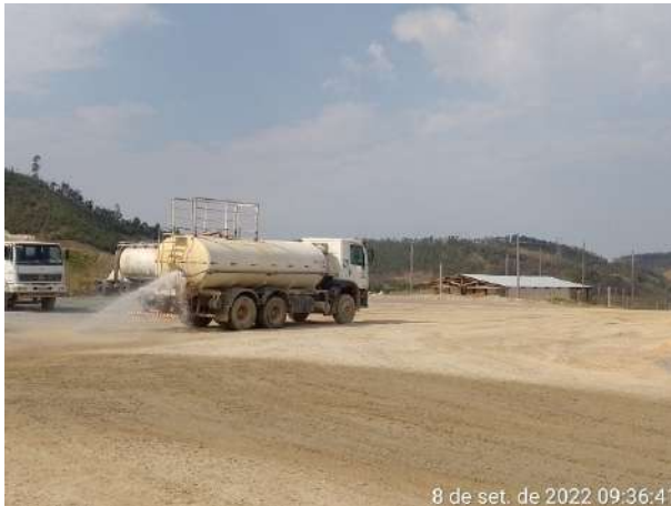
Foto 211 – Realização da umectação das vias internas do canteiro industrial. (Data:08/09/2022)
