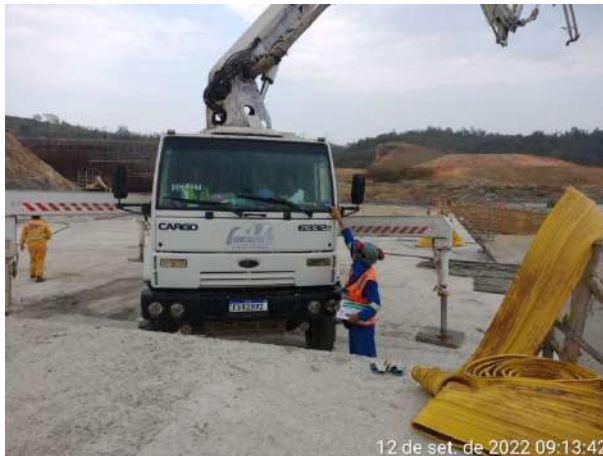
Foto 95 – Caminhão Bomba Lança (CONCRETEI) inspecionado na frente de serviço. (Data:12/09/2022)
