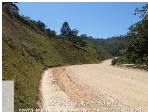
Foto 176 – Sistema de drenagem implantada na estrada de acesso ao empreendimento. (Data:09/12/2022)
