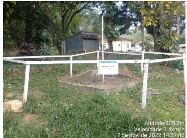
Foto 198 – Biodigester 02 no canteiro administrativo. (Data:07/11/2022)
