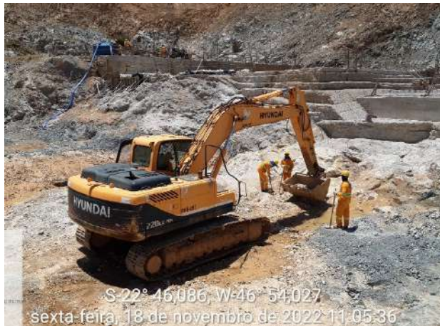
Foto 259 – Vista da realização das atividades construtivas na frente de serviço. (Data:18/11/2022)
