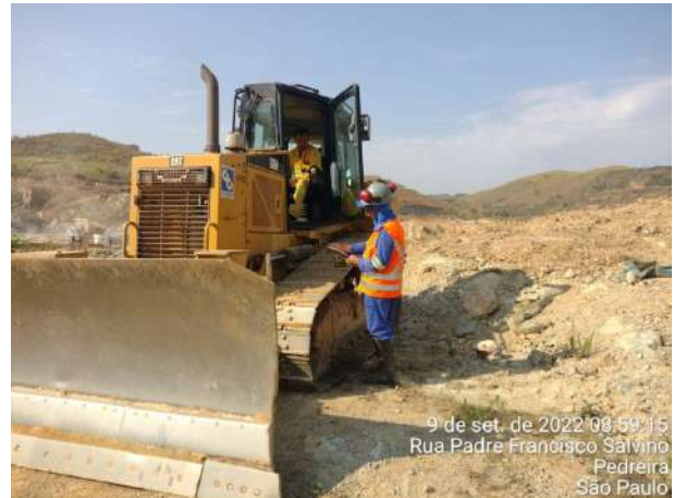
Foto 94 – Trator de Esteira inspecionada na frente de serviço. (Data:09/09/2022)
