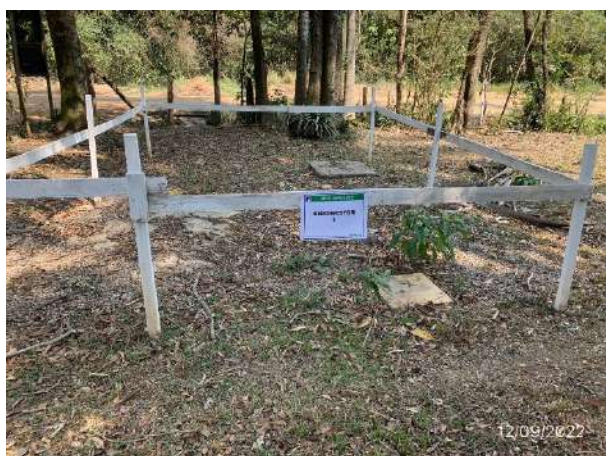
Foto 187 – Biodigestor 01 no canteiro administrativo. (Data:12/09/2022)
