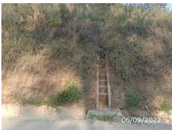
Foto 165 – Escada hidráulica implantada na estrada de acesso ao empreendimento. (Data:06/09/2022)
