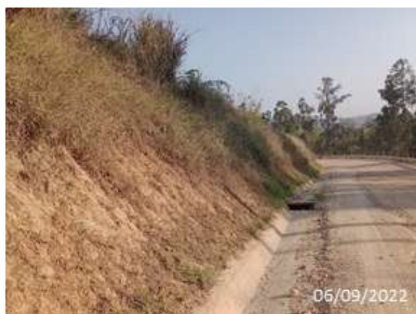
Foto 166 – Sistema de drenagem implantada na estrada de acesso ao empreendimento. (Data:06/09/2022)
