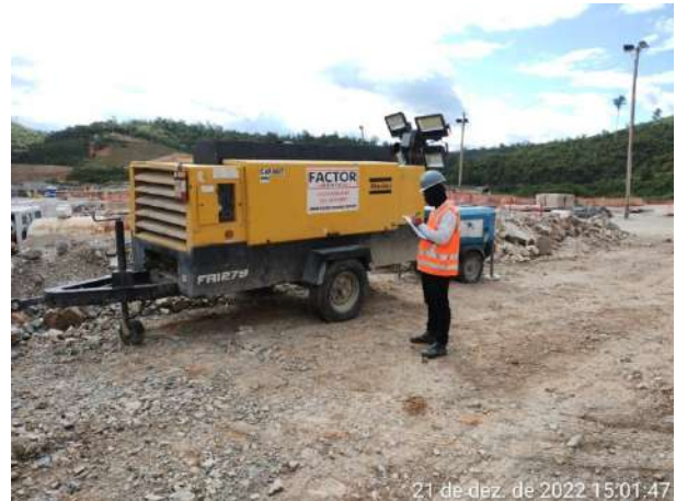
Foto 106 – Inspeções dos compressores na frente de serviço. (Data:21/12/2022)
