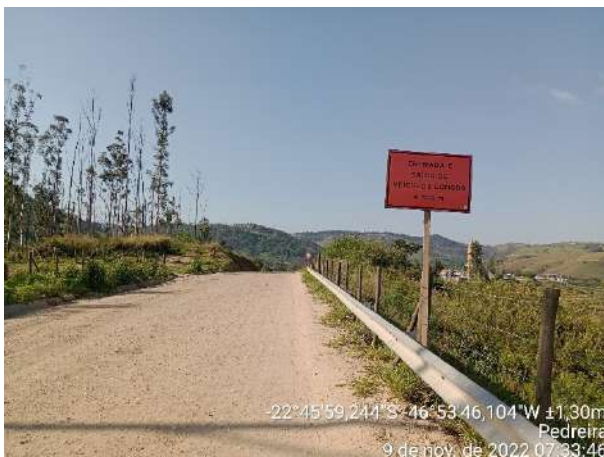
Foto 159 – Sinalização vertical implantada em via externa. (Data:09/11/2022)
