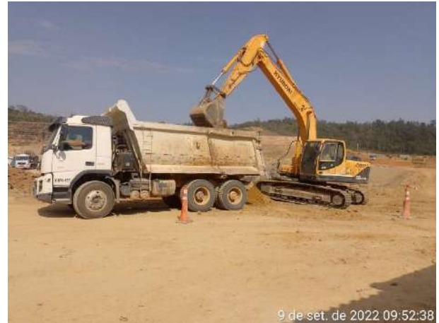
Foto 250 – Vista da realização do carregamento de solo na frente de serviço. (Data:09/09/2022)
