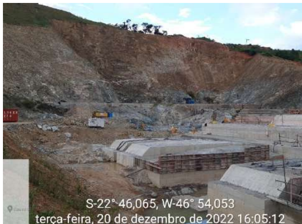
Foto 261 – Vista geral das atividades construtivas na frente de serviço da fundação. (Data:20/12/2022)
