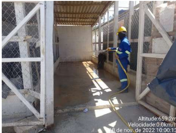
Foto 63 – Limpeza e organização na baía da usina de concreto. (Data: 18/11/2022)
