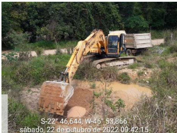
Foto 171 – Manutenção da cacimba implantada em via externa do empreendimento. (Data:22/10/2022)
