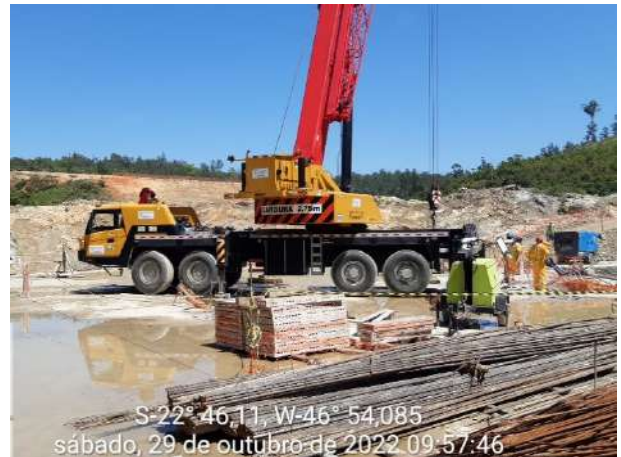
Foto 256 – Vista da realização das atividades de concretagem na frente de serviço. (Data:29/10/2022)
