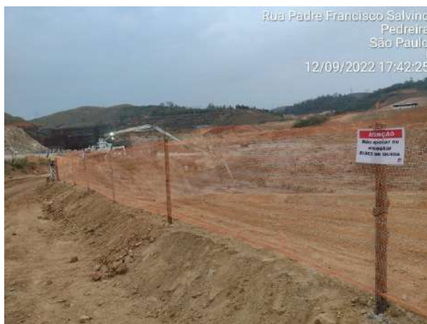
Foto 149 – Sinalização com cerquite implantada em talude de aterro. (Data:12/09/2022)
