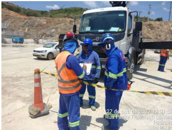
Foto 99 – Caminhão Bomba Lança (CONCRERETI) inspecionado na frente de serviço. (Data:27/10/2022)
