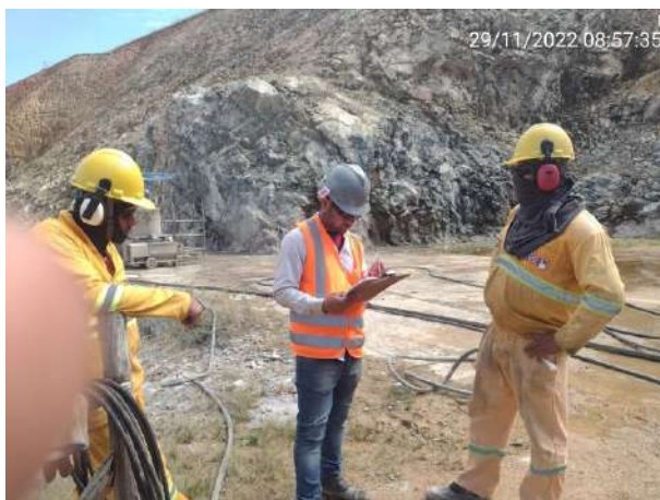
Foto 103 – Compressor - Inspecionado na frente de serviço. (Data:29/11/2022)
