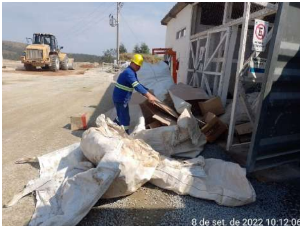
Foto 53 – Organização dos resíduos armazenados na baía destinada para o descarte de papel – Canteiro Industrial. (Data:08/09/2022)
