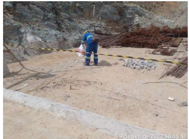
Foto 56 – Limpeza e organização na área de estocagem de ferragens na frente de serviço. (Data:19/09/2022)
