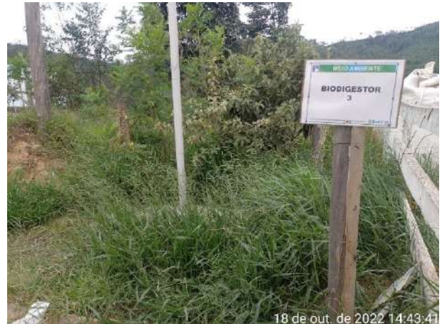
Foto 194 – Biodigestor 03 no Canteiro Industrial. (Data:18/10/2022)
