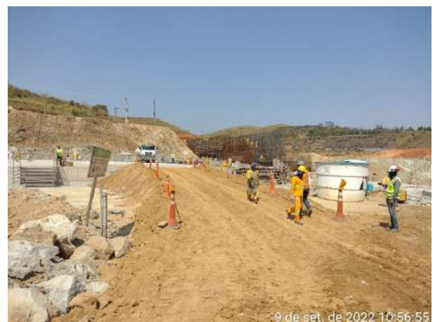
Foto 150 – Sinalização com cones implantada em via interna. (Data:09/09/2022)
