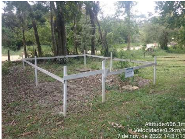
Foto 197 – Biodigester 01 no canteiro administrativo. (Data:07/11/2022)
