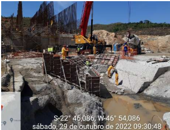
Foto 255 – Vista da realização das atividades de concretagem na frente de serviço. (Data:29/10/2022)
