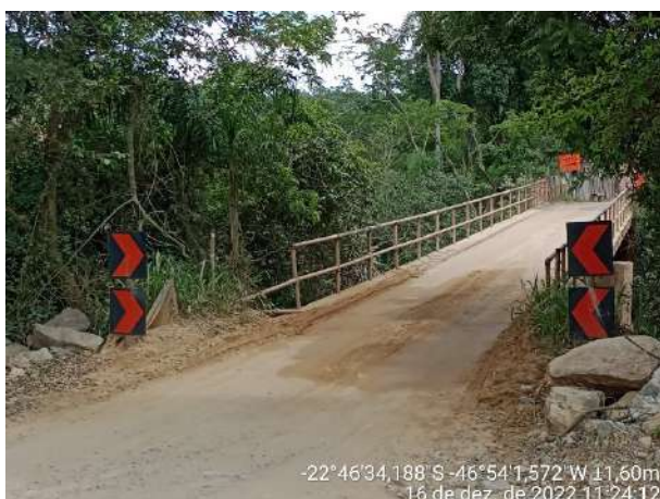
Foto 163 – Sinalização vertical implantada na via externa da obra. (Data:16/12/2022)
