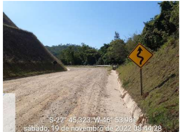
Foto 158 – Sinalização vertical implantada em via externa. (Data:19/11/2022)
