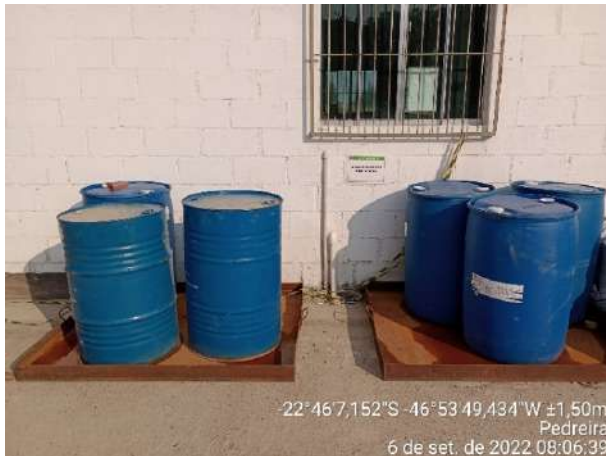
Foto 27 – Vista de tambores de aditivos dispostos em bandejas de contenção na frente de serviço. (Data:06/09/2022)
