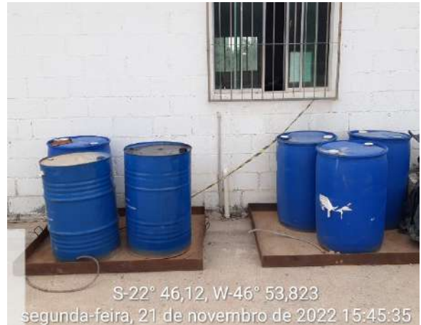
Foto 38 – Vista de tambores de aditivos dispostos em bandejas de contenção na frente de serviço. (Data:21/11/2022)
