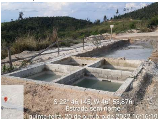
Foto 181 – Sistema de Tratamento de Efluentes utilizado para coleta de resíduos de concreto das betoneira. (Data:20/10/2022)
